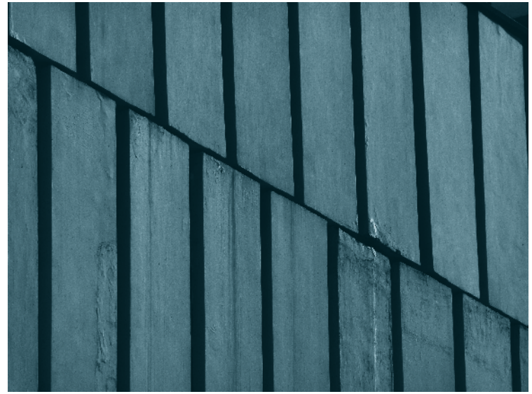
Paneles de hormigón prefabricado de la fachada del edificio Copacabana.
