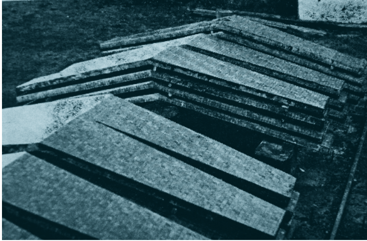
Paneles de hormigón prefabricado revestidos en mosaico vítreo para la fachada del edificio Lido. Revista de la Construcción número 36, mayo de 1965, pág. 65.
