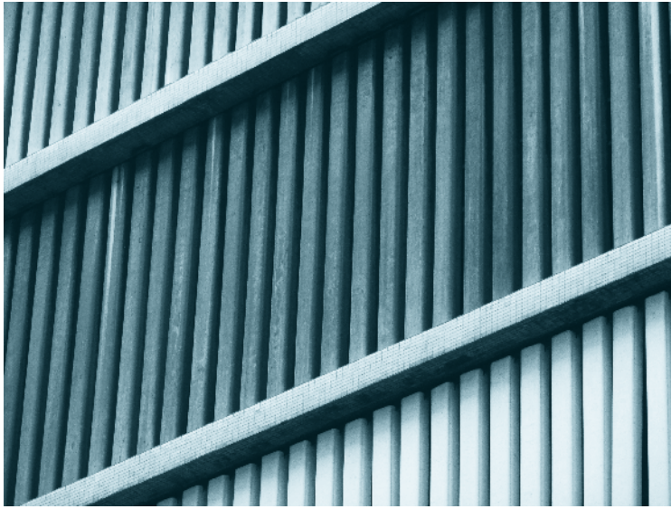
Perfiles de pizarreño del edificio de estacionamientos de Agustinas esquina Miraflores.
