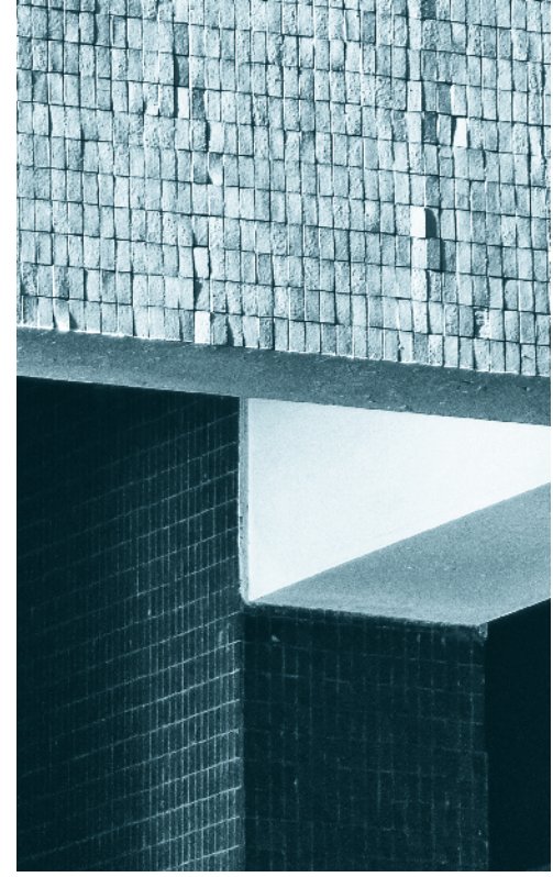
Detalle del revestimiento edificio Merced.
