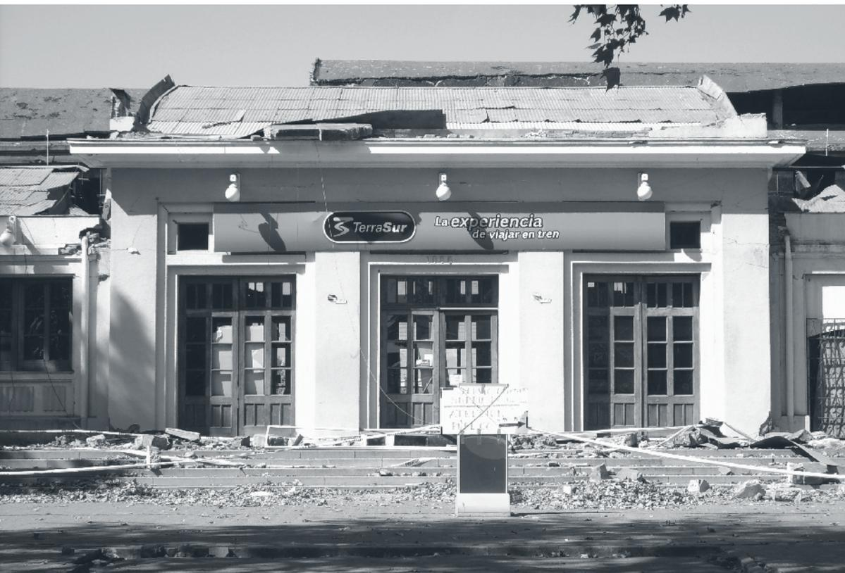
**Estación:** Al igual que muchas construcciones, destaca la caída del remate decorativo logrado mediante la elevación de la fachada, en muchos casos soporte de iconografía de influencia prehispánica.
