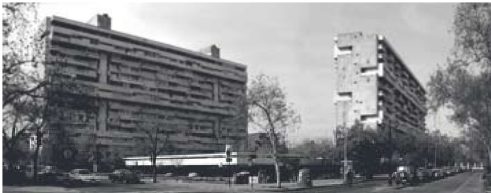
Remodelación República. (1965 – 1969) Arquitectos: CORVI; Vicente Bruna, Víctor Calvo, Jaime Perelman y Orlando Sepúlveda. Dirección: República 618 y 702 (Esq. Gay). Gentileza Joaquín Velasco.
