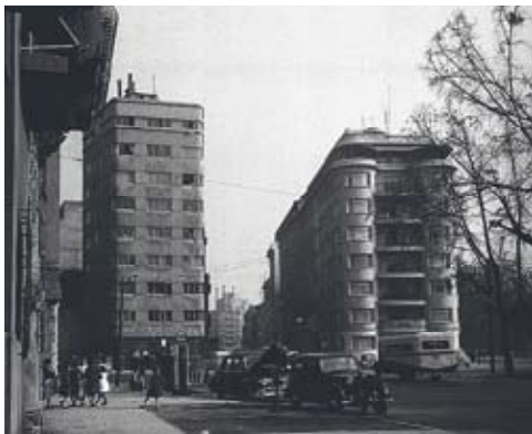
Edificio Merced. (1939 – 1946) Arquitectos: Luis Herreros y Ernesto Fones. Dirección: Merced 293. Archivo Fotográfico Universidad de Chile.
