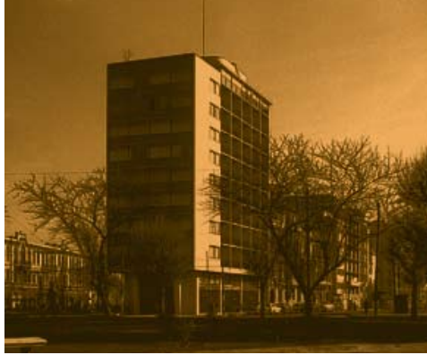
Edificio Plaza Baquedano. (1953 – 1957) Arquitectos: Manuel Marchant Lyon y Santiago Roi. Dirección: Merced 22. (Esq. Alameda Bernardo O'higgins). Archivo Fotográfico Universidad de Chile.
