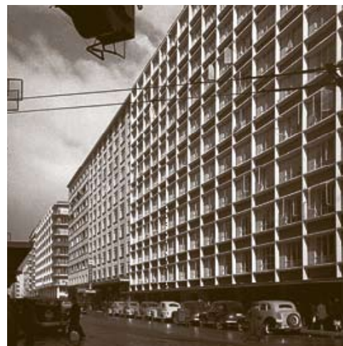
Edificio Mac-Iver. (1951 – 1954) Arquitectos: Osvaldo Larraín, Jaime Larraín y Jaime Sanfuentes. Dirección: Mac-Iver 180. (Esq. Agustinas). Archivo Fotográfico Universidad de Chile.
