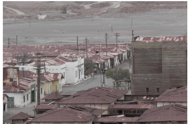
Figura 8: Vista de una de las calles principales de Humberstone, se aprecia el teatro y al centro el club social. Fuente: Fotografía de Juan Carlos Jeldes.
