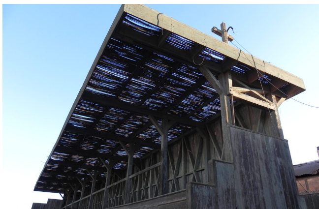
Figura 5: Gradas y marquesina de la piscina de Humberstone.
