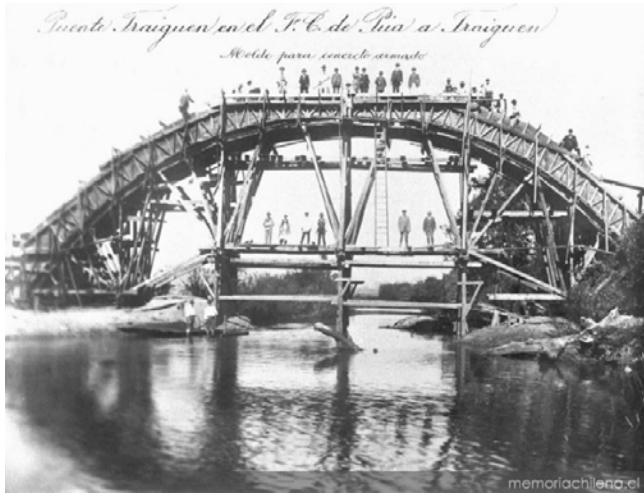
Figura 3. Vista del molde para concreto armado utilizado para construir el puente ferroviario sobre el río Traiguén, entre Púa y Traiguén, 1920. Fuente: Colección Museo Histórico Nacional.
