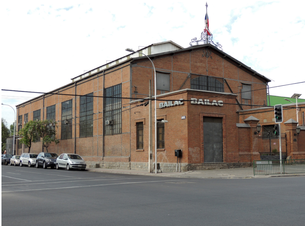
Figura 5. Subestación de calle Mapocho, 1908-09, Santiago de Chile. Fuente: Fotografía de Ronald Harris, 2018.
