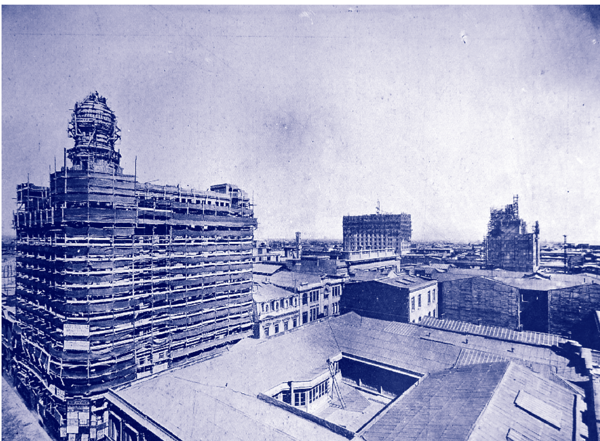
Fotografía de E. Merton para el reportaje "Construir". A la izquierda el edificio del Banco Sudamericano y al fondo, el Ministerio de Hacienda durante su construcción. El pie de foto reza: "Construir. Los rascacielos perfilan sus siluetas airosas y esbeltas sobre la masa uniforme de la ciudad antigua". Arquitectura y Arte Decorativo , 11, (1930), 469.
