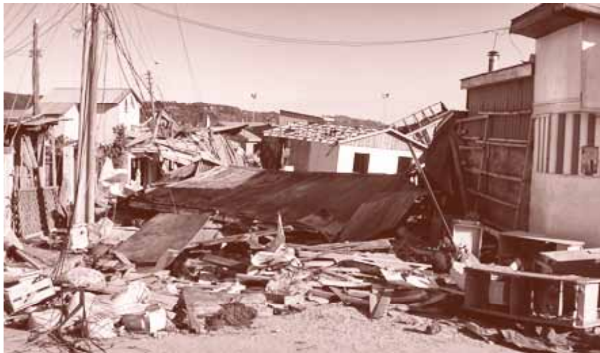
Calle Serrano con impacto de tsunami. Fuente: Iván Cartes.
